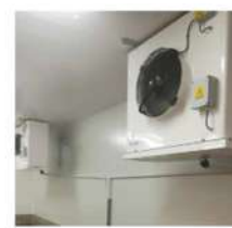
Modernisation des systèmes de froid L'Herbaudière, Le Croisic
