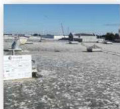
Réfection toiture Les Sables d'Olonne
